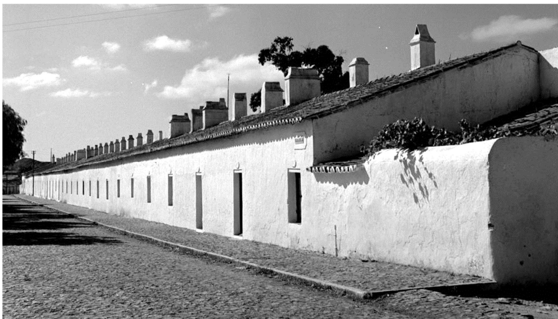
Fig. 3. Exemplo da típica agregação linear de edifícios de arquitetura tradicional alentejana (fonte: Artur Pastor, Minas de São Domingos, meados do séc. XX).
