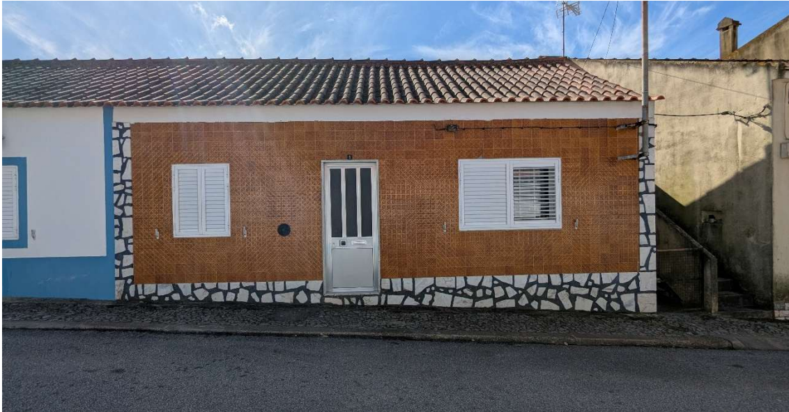
Fig. 10. Edifício do núcleo original do Monte das Piçarras descaracterizado pela adição de elementos dissonantes na Rua 28 de Setembro (fonte: CMVN).
