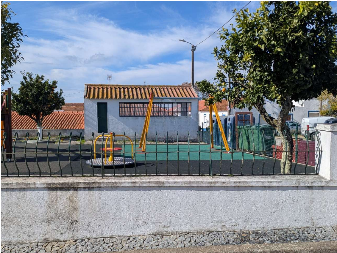
Fig. 5. Largo 7 de setembro. Espaço público constituído por um Parque Infantil e um abrigo para transportes coletivos com Instalações Sanitárias anexas no piso inferior (fonte: CMVN).
