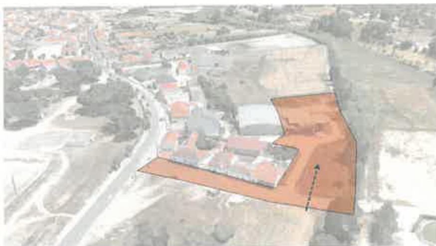
Figura 12. Unidade de Intervenção 2
