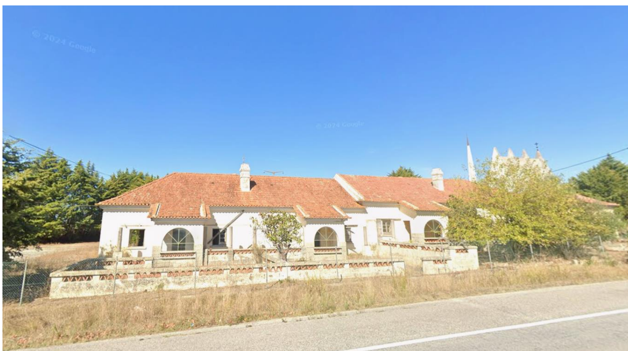
Fig. 9. Núcleo a norte da EN4, unidade residencial, da antiga estação recetora da Companhia Portuguesa Rádio Marconi.
