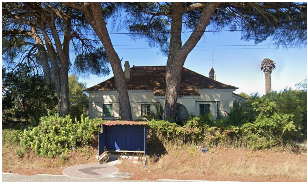
Fig. 11. Núcleo a norte da EN4, unidade residencial, da antiga estação recetora da Companhia Portuguesa Rádio Marconi.
