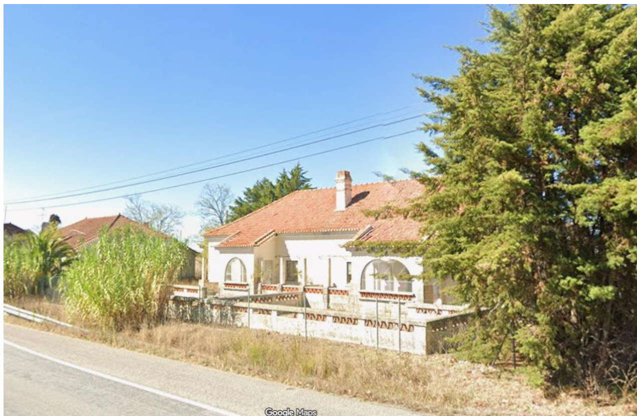
Fig. 10. Núcleo a norte da EN4, unidade residencial, da antiga estação recetora da Companhia Portuguesa Rádio Marconi.
